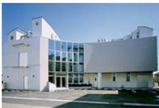
原子力センター福島支所全景
