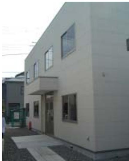
新しい施設は既存のラドン測定庫を取り壊した跡地に建設されました。延べ床面積は151m<sup>2</sup>で、鉄骨造りの2階建てです。1階にはラドン測定器に取り付けられたフィルムをエッチングするエッチング室、エッチングされた後に生成したエッチピットを計数する計数作業室(写真下)ラドン濃度測定器の発送及び回収作業を行う準備室があります。2階にはラドン濃度測定器を保管する保管室とデータの解析作業を行う作業室があります。
